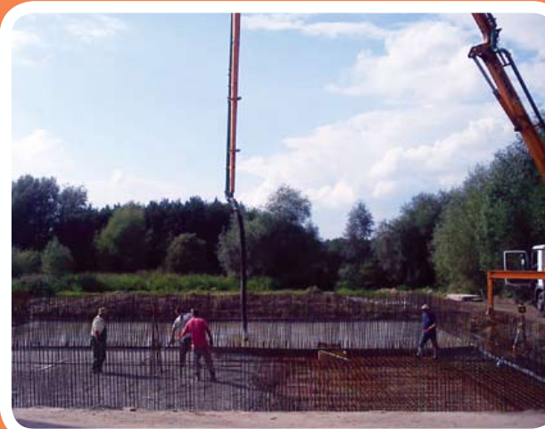
Betonowanie płyty dennej bioreaktora oczyszczalni
