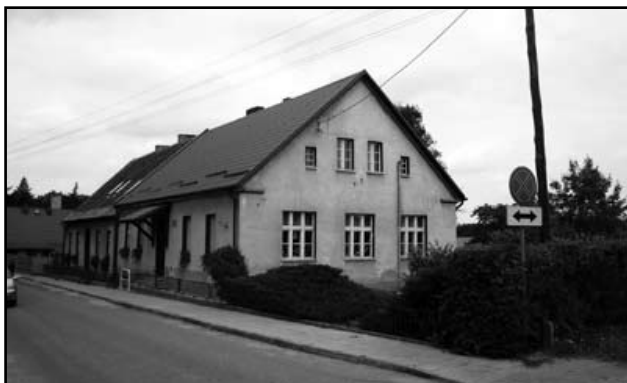
Nowy dach na przedszkolu przy ul. Spokojnej we Włoszakowicach
