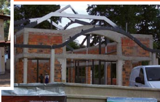
Natomiast na plaży głównej w Boszkowie rozpoczęto budowę restauracji letniej
