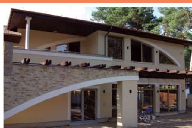
Postępują prace przy budowie nowoczesnego kompleksu turystyczno - konferencyjnego „Vitalia” przy ul. Dominickiej w Boszkowie - Letnisku. Otwarcie planowane jest jeszcze tej jesieni
