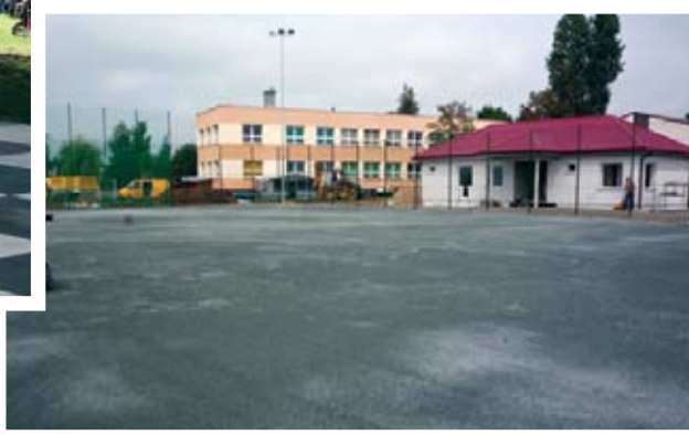
„Orlik” w Krzycku Wielkim rozwija skrzydła. Przygotowywane jest podłoże pod sztuczną trawę i nawierzchnię tartanową. Na ukończeniu jest też budowa zaplecza socjalnego - szatni, ogrodzenia i oświetlenia
