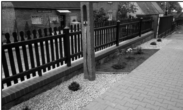
Szkoła w Dłużynie: nowy płot przed wejściem głównym
