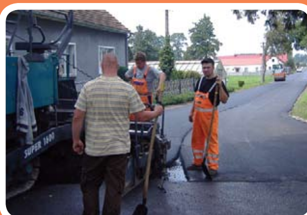
Ułożono nawierzchnię asfaltową o długości 550,0 mb i szerokości 5,50 m w miejscowości Skarżyn. Wykonawcą wylonionym w przetargu nieograniczonym została firma PHU Ryszard Antkowiak z Krzycka Wielkiego. Inwestycja jest współfinansowana przez Urząd Marszałkowski Województwa Wielkopolskiego z Funduszu Ochrony Gruntów Rolnych w kwocie 51.000,00 zł.
