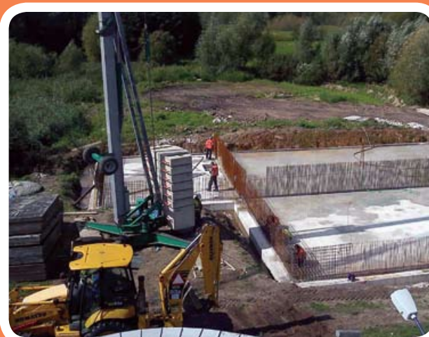
Zbrojenie ścian bioreaktora rozbudowywanej oczyszczalni ścieków w Grotnikach
